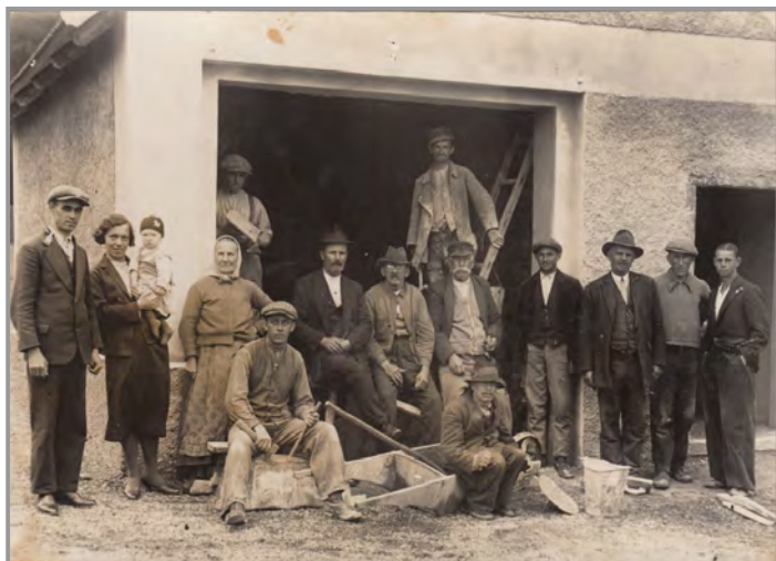
Stavba hasičské zbrojnice v Novém Podlesí 1922
